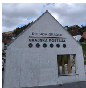
Slika 7: Napis na objektu
